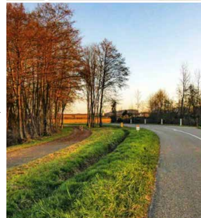
Exemple de piste cyclable en site propre, contiguë à une chaussée mais protégée par un bon séparateur (Carspach, 68).
